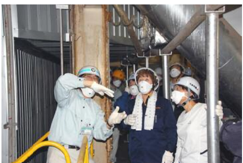
→ 焼却施設内・排ガス処理部分の改修後の状況を視察する岸本市議（写真左）と杉浦市議（中央）
