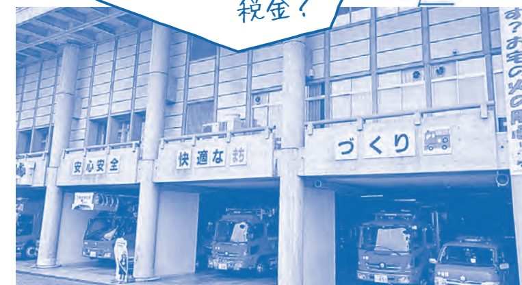
耐震不足のまま何年も経過する中消防署（市役所別館）
