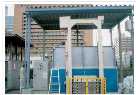
東京築地卸売市場の分解消滅型生ごみ処理機。微生物が有機物を分解します
