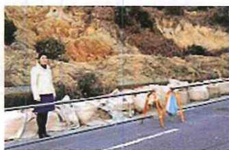
▲崖崩れの現場を調査
