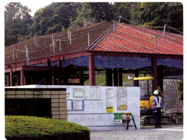
現在、建設中の志賀聖苑
