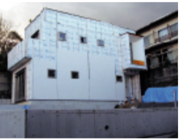
▲市内でリフォーム中の民家
