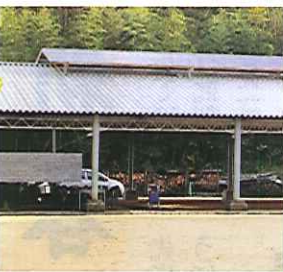
▲完成後の補助金申請での補助金でつくられた屋根
