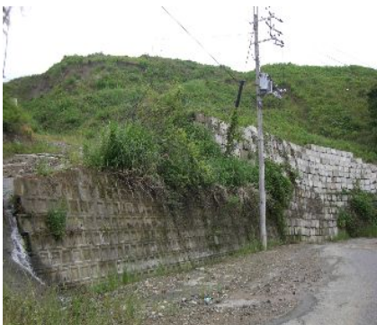
路面から約50メートルがさ上げされた現場
